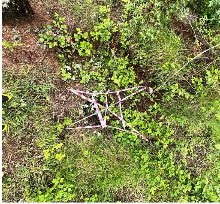
Görsel 1 – İşaretlenmiş su borusu vanaları
